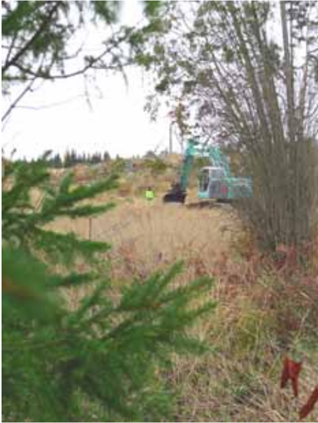
Figur 13. Schaktning på den gamla åkermarken i den västra delen av skogen. Från norr. Foto: Ann Lindkvist, SAU.
